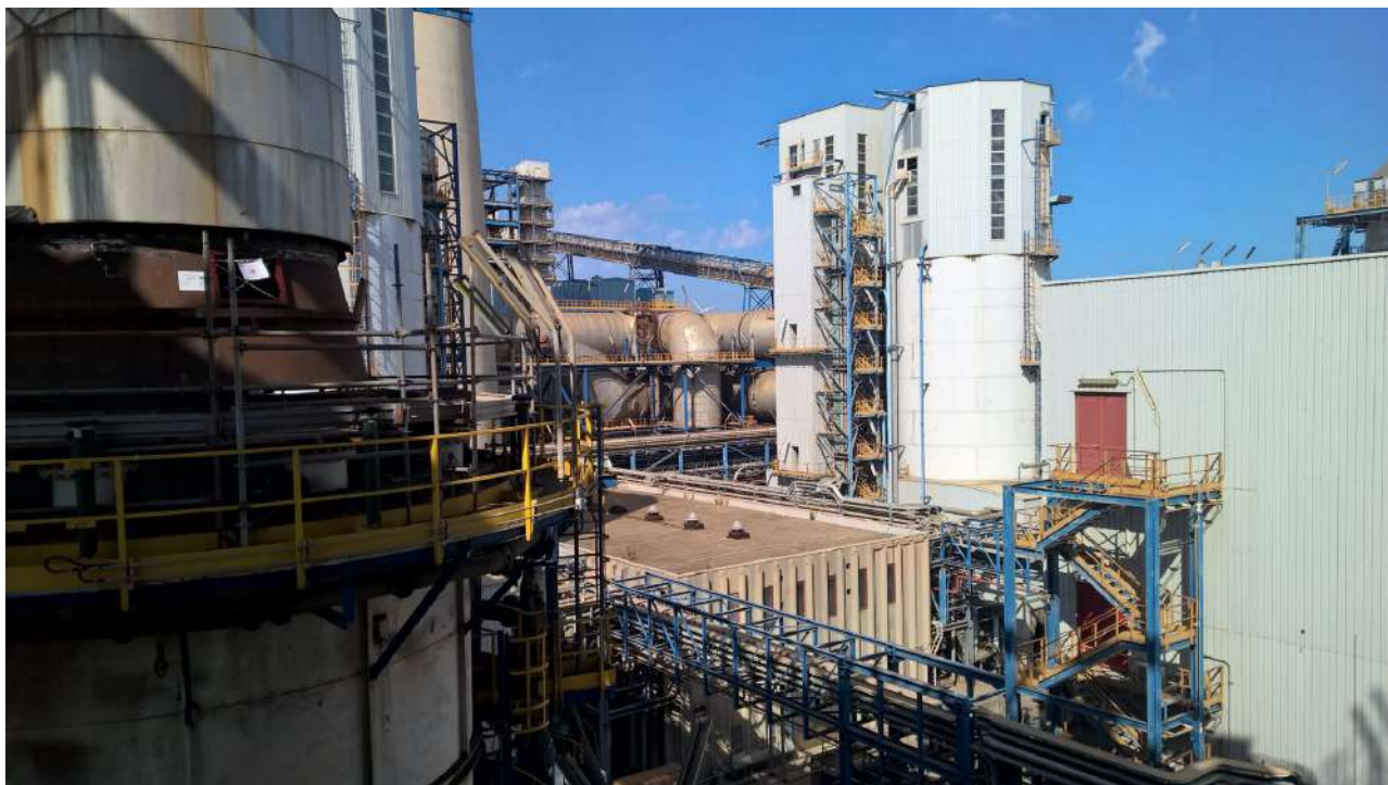
Impianti di desolforazione dei fumi
