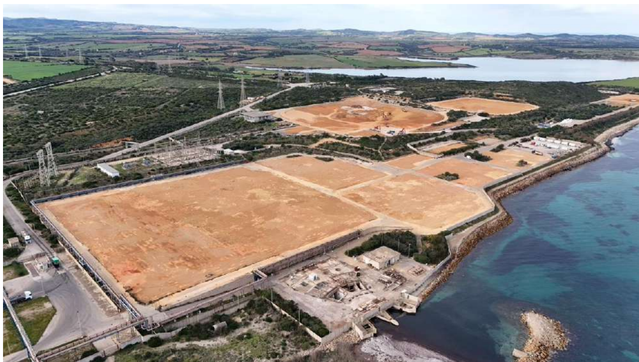
In primo piano l'area ripristinata dei vecchi gruppi 1 e 2 a olio demoliti.
